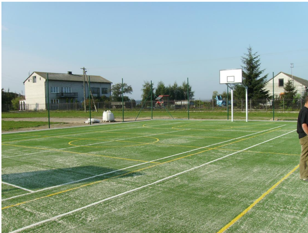
Fot. Boisko wielofunkcyjne przy ZSO w Kroczewie
