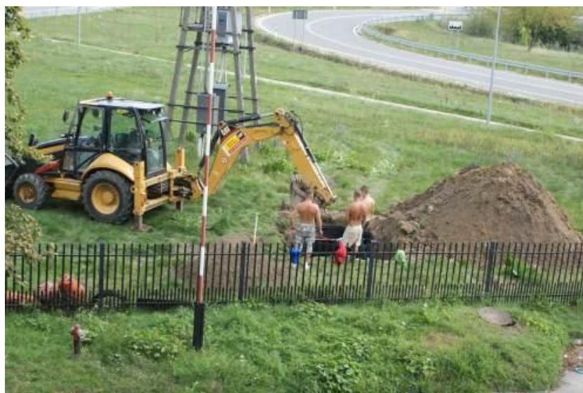
Fot. Budowa przydomowej oczyszczalni ścieków przy UG Załuski. 2008 rok
