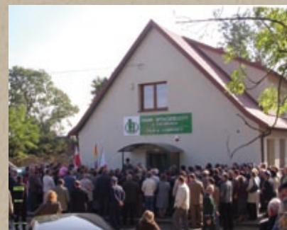
W budynku przedwojennej szkoły w Kamienicy w 2008 r. otwarto filię Banku Spółdzielczego w Załuskach. Fot. Jarosław Maciej Zawadzki
