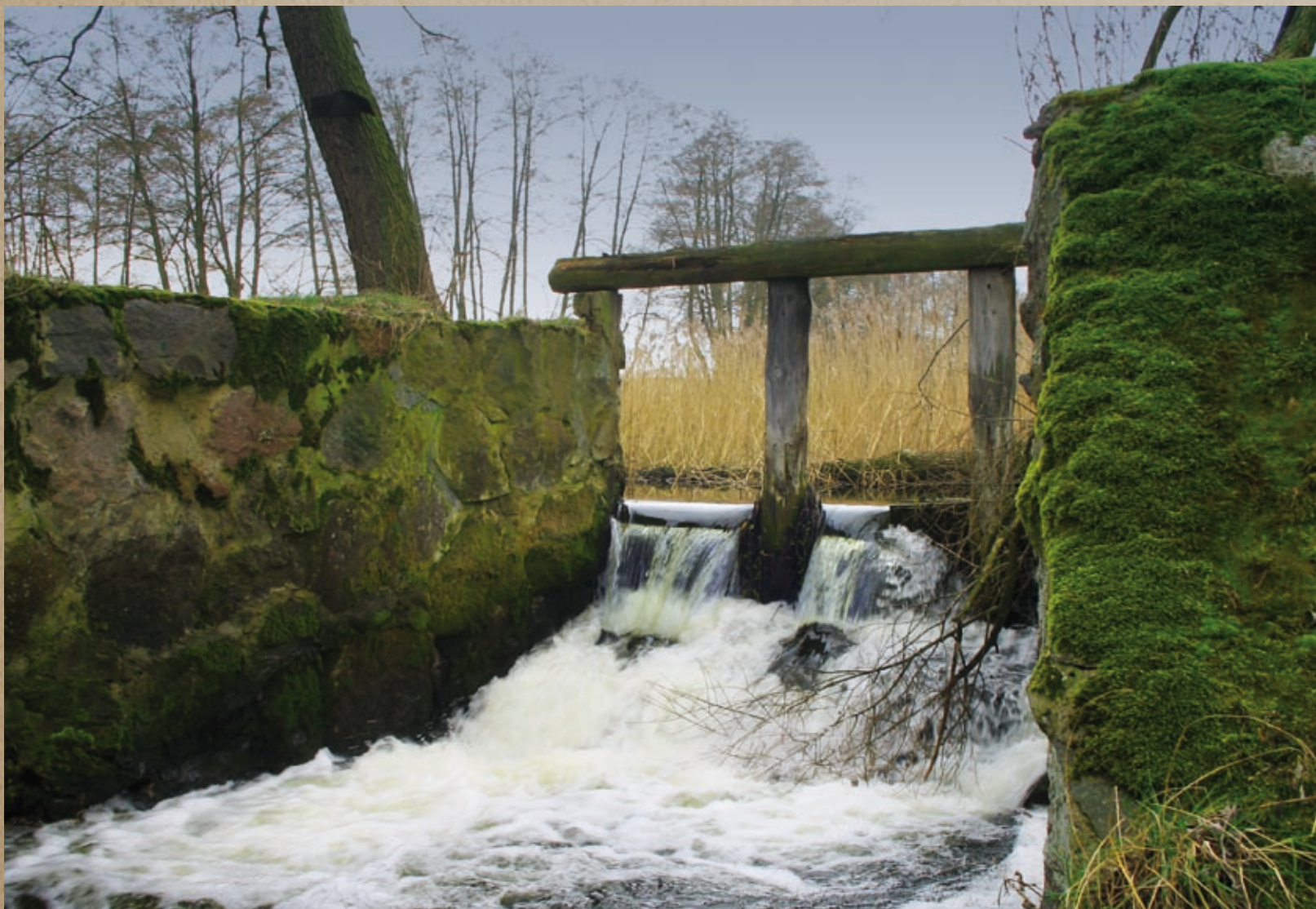
Pozostałości stawideł przy młynie w Szczytnie. Fot. Jarosław Maciej Zawadzki
