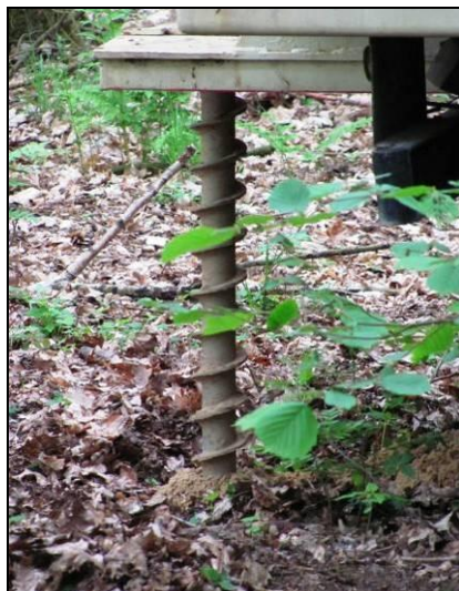
Fot. 11 Wiercenie otworu strzałowego. (Arch. PGNiG SA)
