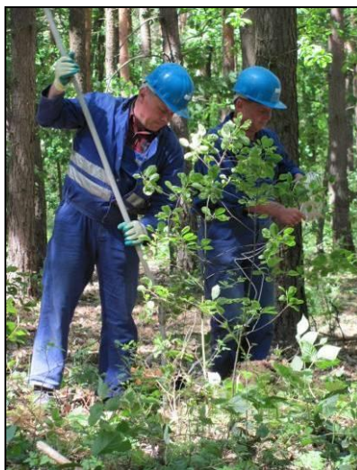
Fot. 25 Umieszczanie ładunku wybuchowego w otworze strzałowym. (Arch. PGNiG SA)
